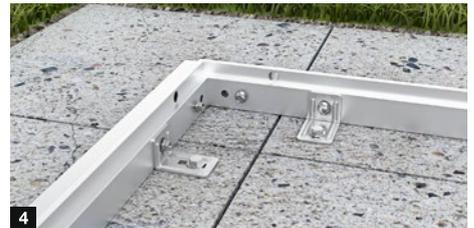
Für eine volle Stabilität und einen sicheren Aufbau der Hörmann Gerätehäuser und Kaminholzregale ist ein waagerechter Unterbau zwingend notwendig. Auf einer gepflasterten, asphaltierten oder betonierten Grundfläche mindestens in der Größe des Gerätehauses werden die Stauraumsysteme verankert und montiert. Sollte der Unterbau nicht waagerecht sein, kann es zu Einschränkungen bezüglich des Aufbaus, der Funktionalität und der Sicherheit kommen.
